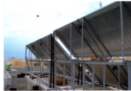
Jeder Vakuumröhrenkollektor wiegt 54 kg und musste auf dem Flachdach gegen die am Meer herrschenden starken Windlasten gesichert werden
